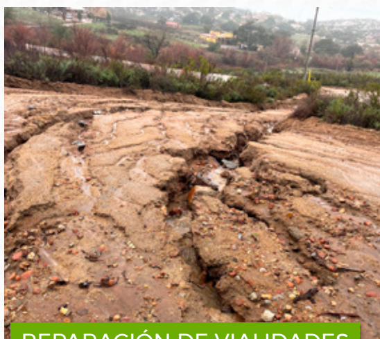
REPARACIÓN DE VIALIDADES AFECTADAS POR LLUVIA
