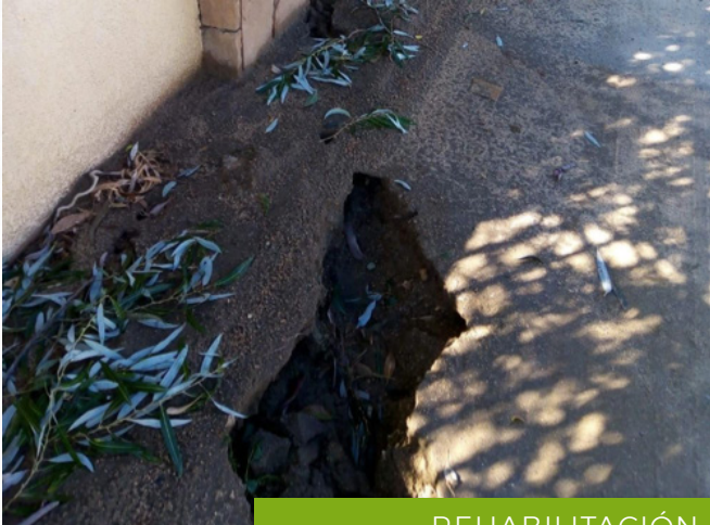
REHABILITACIÓN DE ESTRUCTURA VIAL AFECTADA POR LLUVIAS (SOCAVÓN EN PUENTE DE ACCESO)
